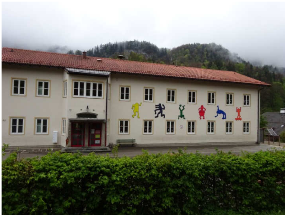
Abbildung 31: Detailprojekt Bad Reichenhall: Gebäudehülle der Grundschule
