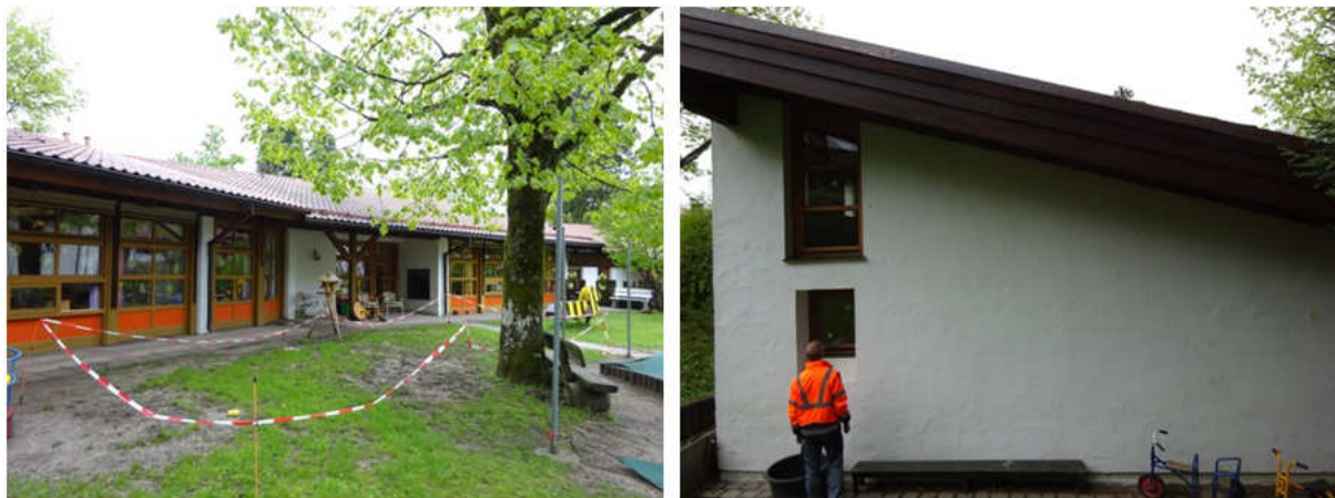
Abbildung 33: Detailprojekt Bad Reichenhall: Gebäudehülle des Kindergartens
