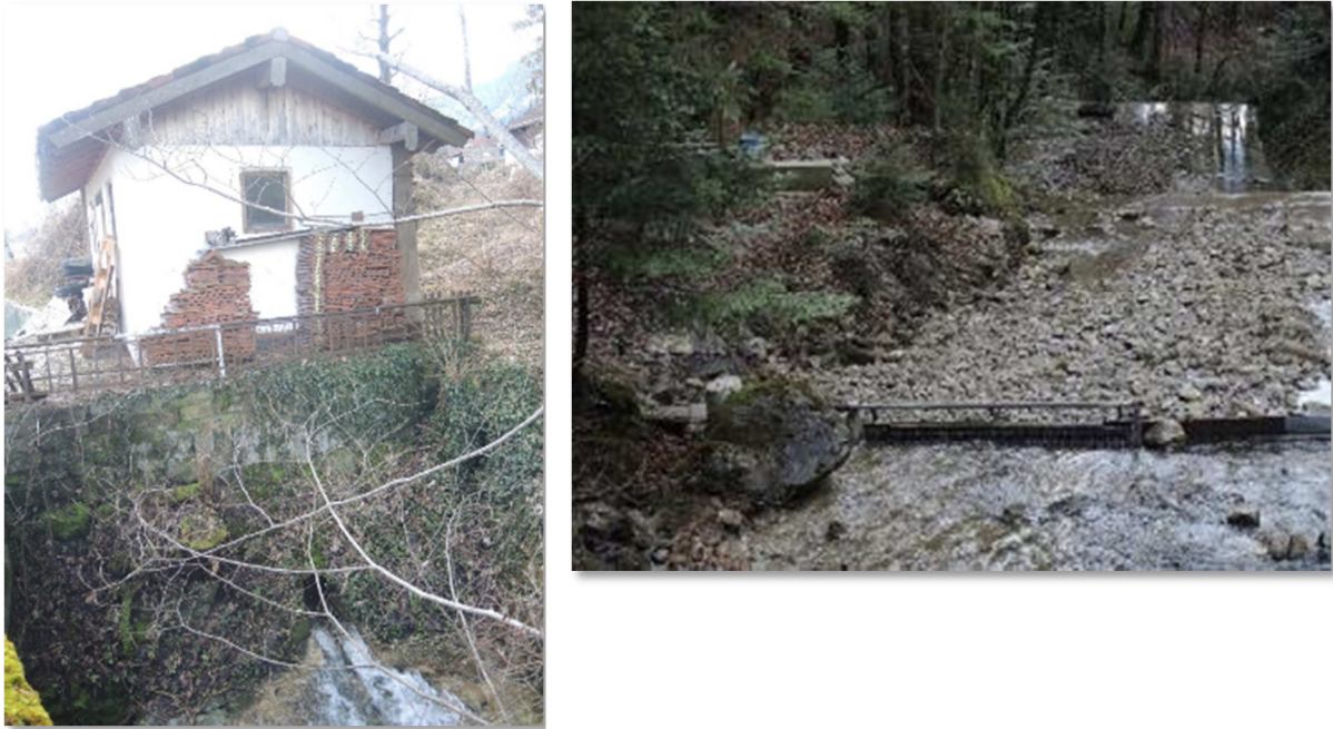
Abbildung 39: Anlagenhaus Schornermühle inkl. Auslass (links), Einlauf- bzw. Ausleitungsbauwerk (rechts)
