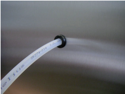
Abb. 7: Geschützte Verlegung der Gasleitung
